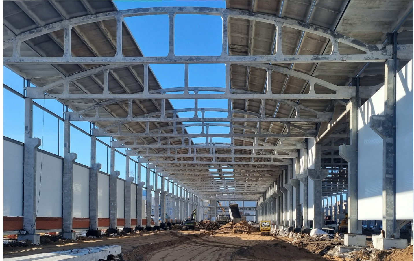
Строящийся корпус. Фактическое состояние на апрель 2024 года
