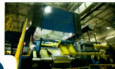
Шестивалковый стан холодной прокатки
