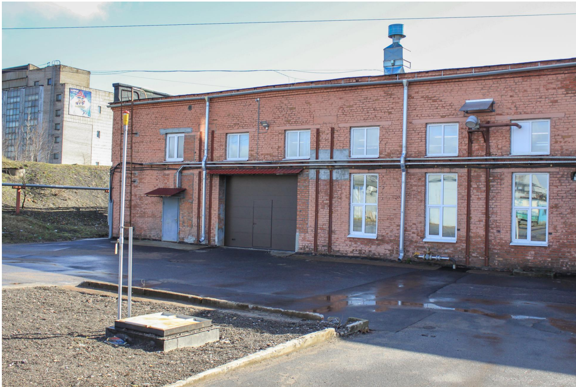
Испытательный комплекс топливных систем и их компонентов. Общий вид.
